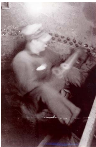
Figure 5 – Au début des années 1940, l'art de poser des rivets était encore en demande. La pose de rivets requerrait cinq hommes pour fermer un joint comparativement à un soudeur.
